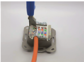
Aufschalten der Aderpaare mit LSA-Werkzeug Terminate the wires with LSA impact tool
