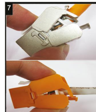
Die Montageklappen schließen -mit diesem Vorgang wird das Modul kontaktiert.
