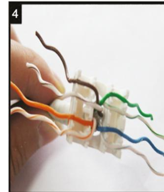
Kabel einführen und die einzelnen Adern nach der von Ihnen gewählten Belegungsvariante in den Kabelsortierer einführen.
